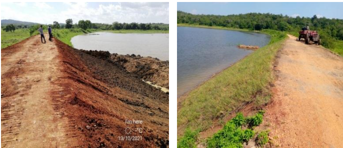
හොරිවිල කුලාන, හොරිවිල වැව දකුණු කෘෂි මාර්ගප්‍රතිසංස්කරණය කිරීම
